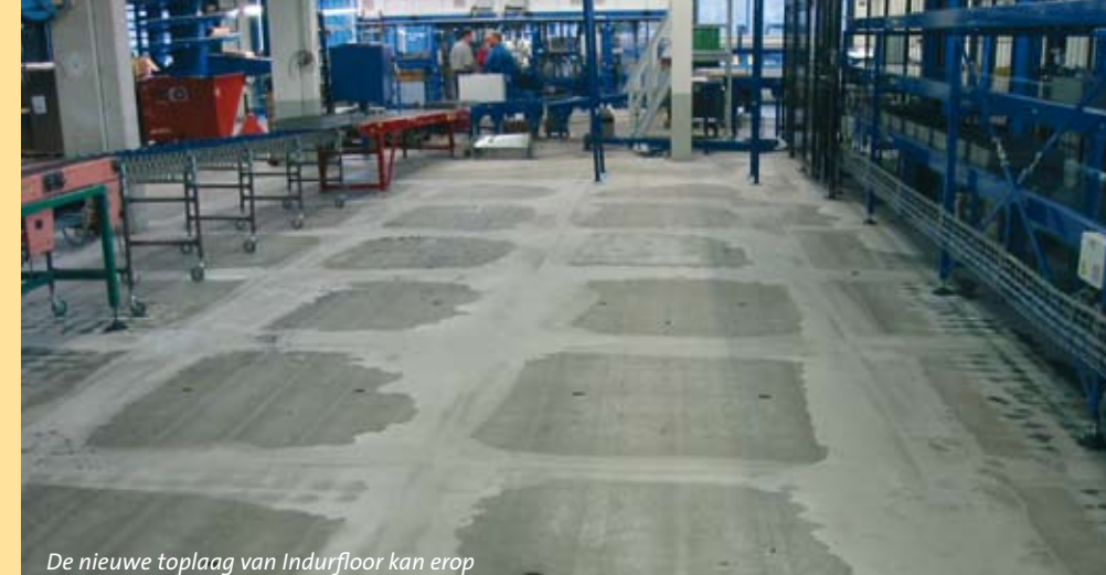
De nieuwe toplaag van Indurfloor kan erop
